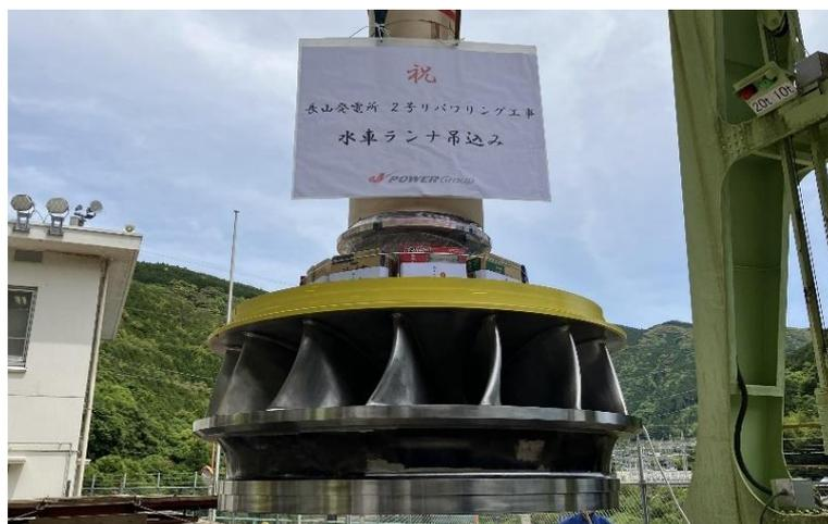
長山発電所2号機リパワリング工事の様子（水車ランナ吊込み）
