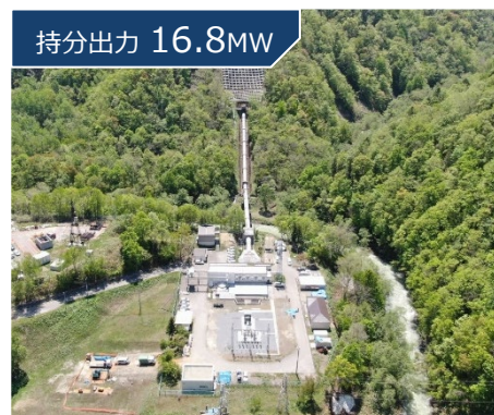
北海道 新桂沢発電所
