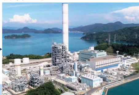
大型化したガス化炉の運転および 高濃度水素によるガスタービン運転の実証試験
