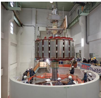
回転子吊り込みの様子（2022年12月）
