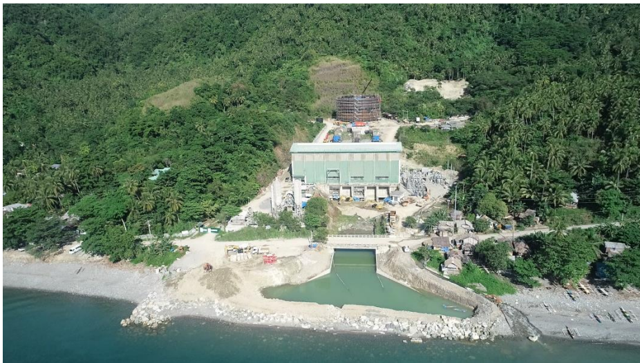
建設中のレイクマイニット水力発電所
