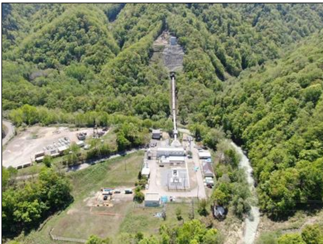
発電所全景（2022年5月18日撮影）
