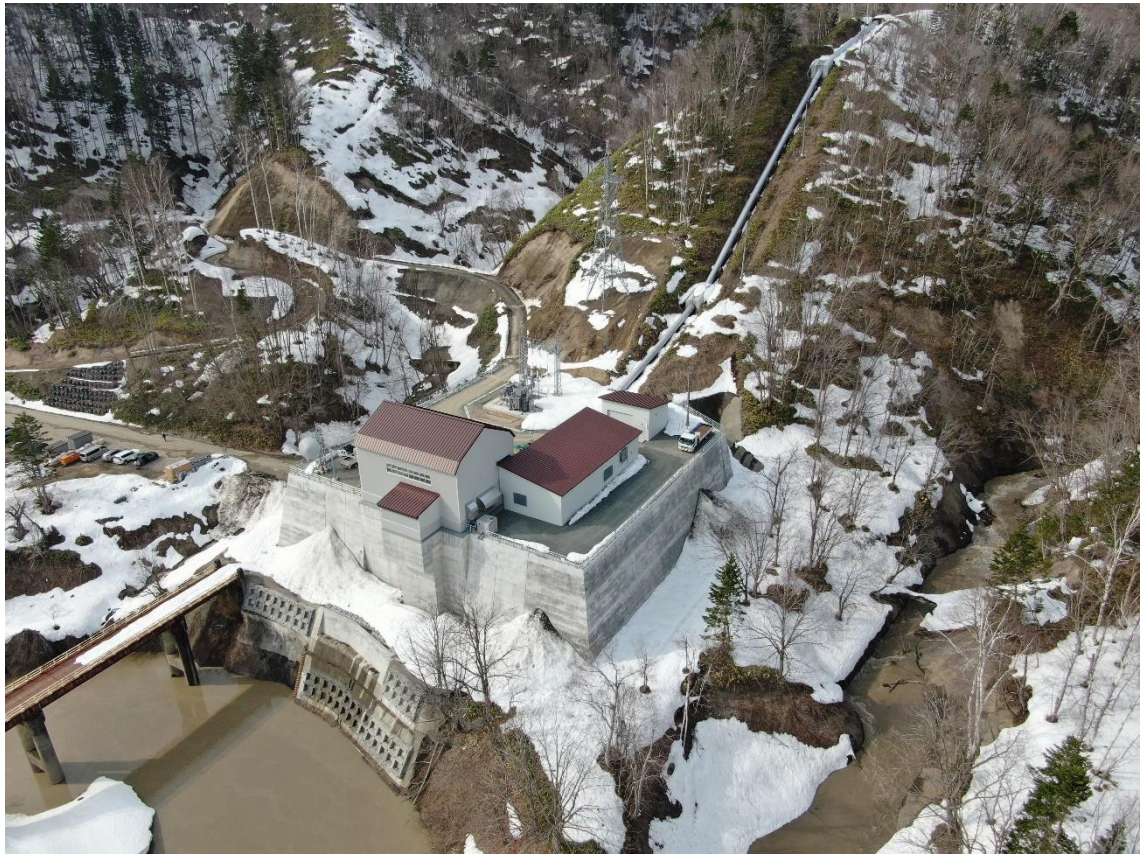
熊追発電所全景（2022年4月11日撮影）
