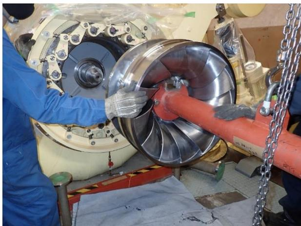
新型水車の据付状況（田子倉発電所）
