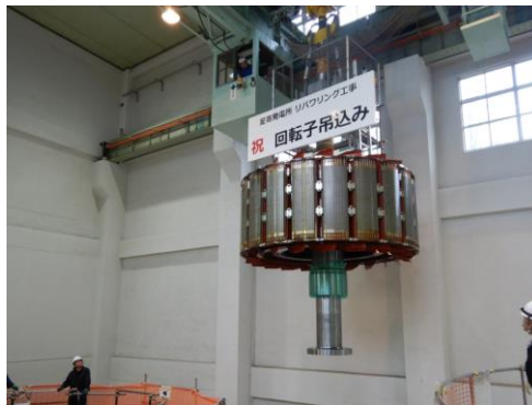
回転子吊り込みの様子（2020年11月）
