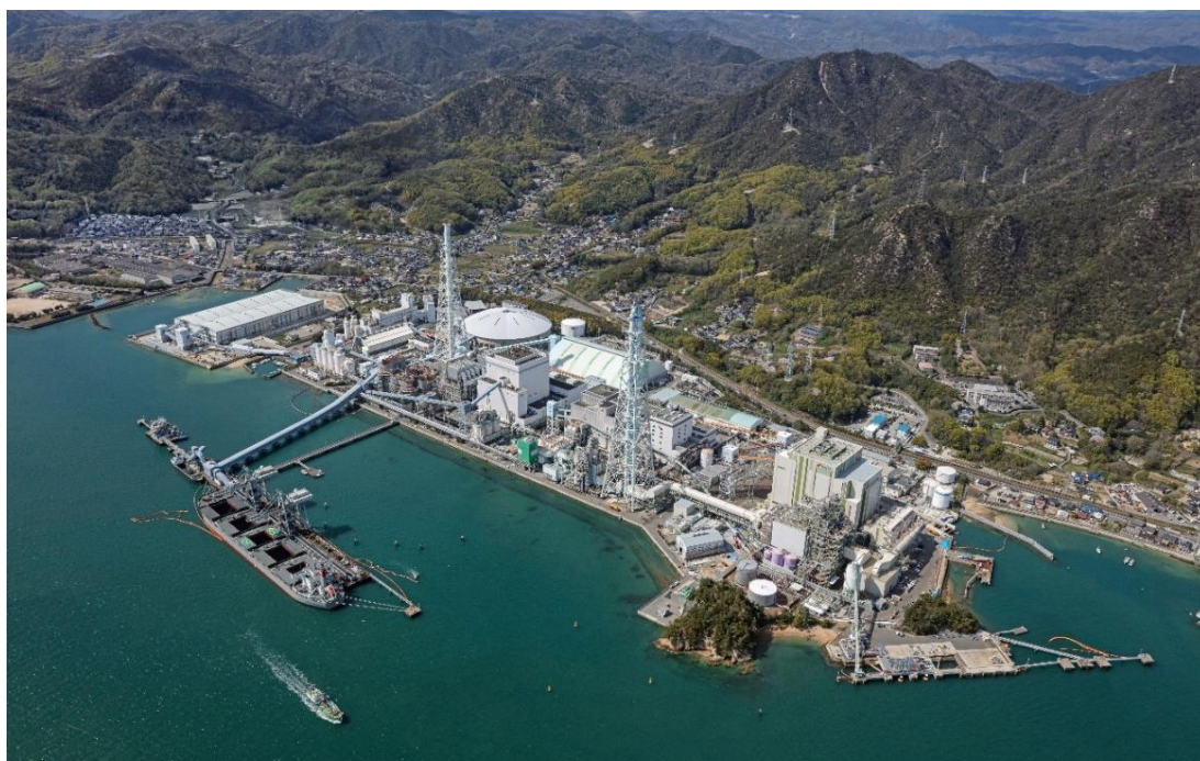
（写真）竹原火力発電所新1号機・3号機全景
