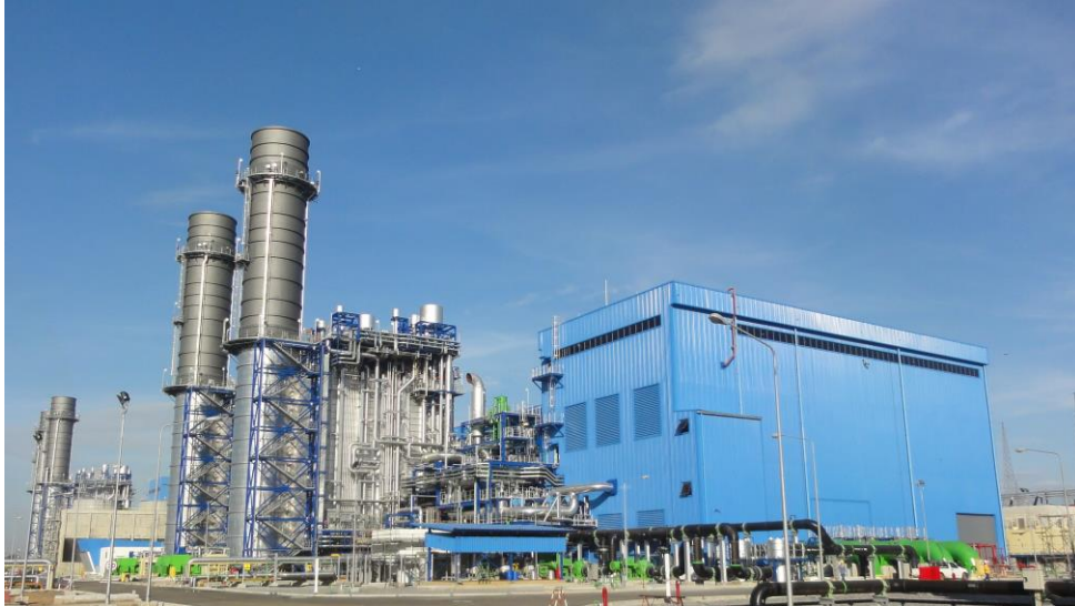
(写真左奥：1 号系列、写真手前：2 号系列)
