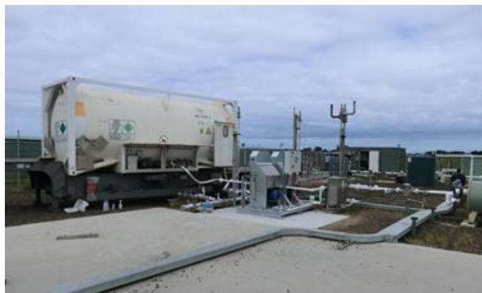
CO 2 圧入試験の様子
