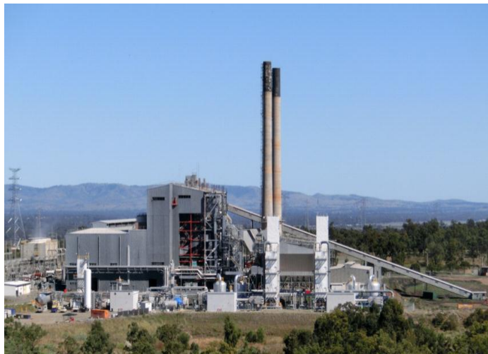
カライド A 発電所全景
