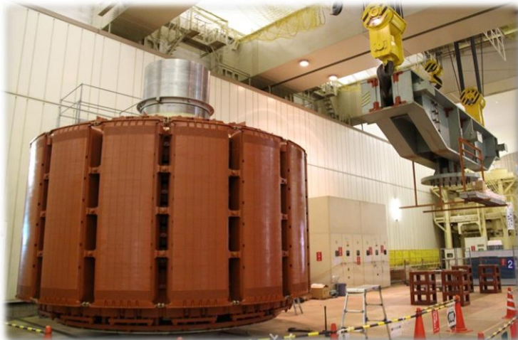
[下郷発電所におけるオーバーホール工事]
