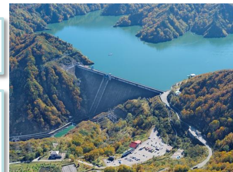
奥只見発電所
