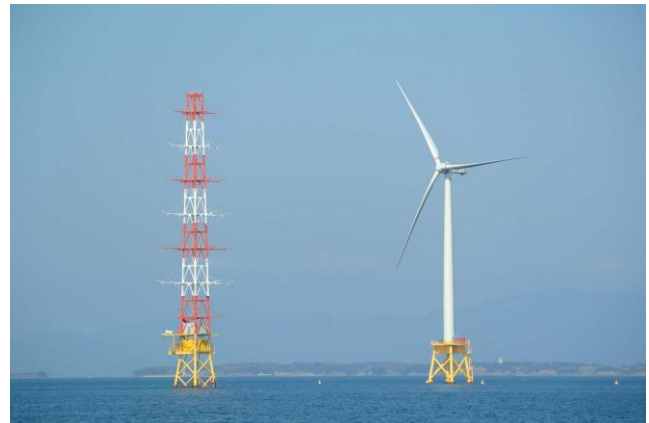
運転を開始した洋上風車 (左は既に観測中の洋上風況観測タワー)
