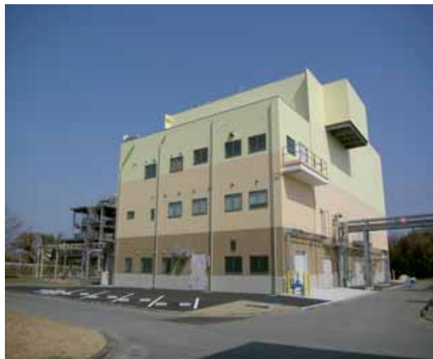
燃料化施設外観
