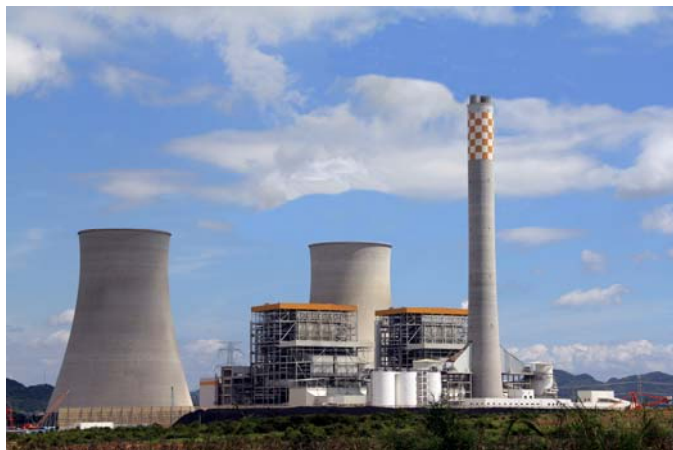
<賀州発電所（右が1号機、左が2号機）>
