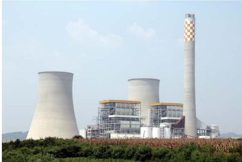
<賀州発電所（右が1号機、左が2号機）>
