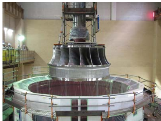
1 号機水車ランナ吊り込み式の様子（平成 23 年 11 月）
