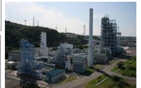
EAGLEパイロット試験設備(福岡県)
