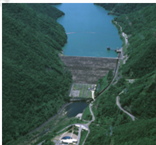
御母衣発電所(岐阜県)
