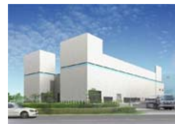
下水汚泥燃料化施設(広島県)
