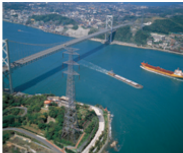
関門連系送電線 (山口県・福岡県間)
