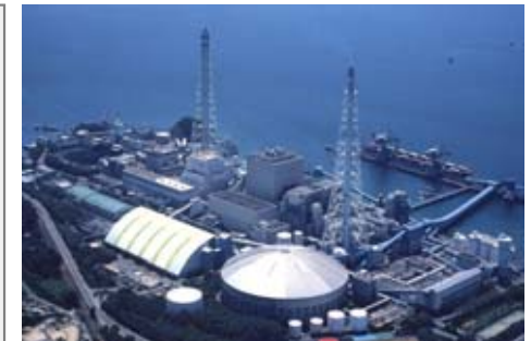
竹原火力発電所(広島県)
