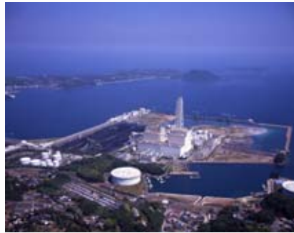
松浦火力発電所(長崎県)
