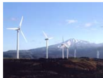
仁賀保高原風力発電所(秋田県)
