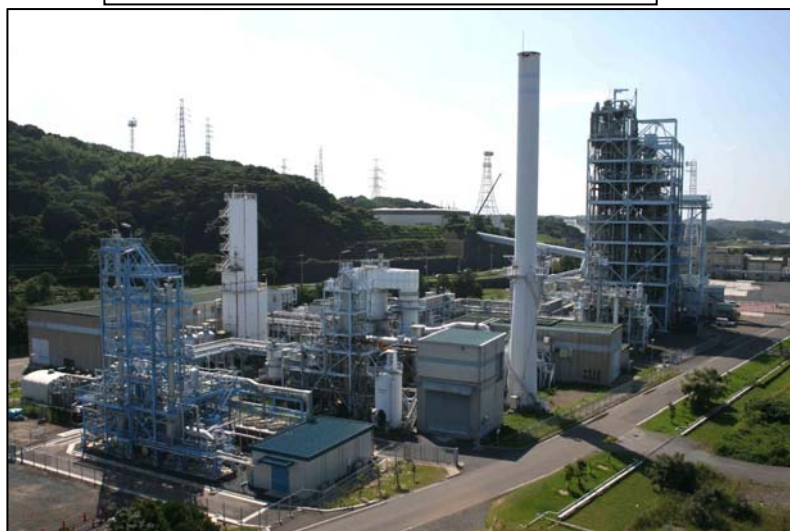
EAGLE パイロット試験設備
