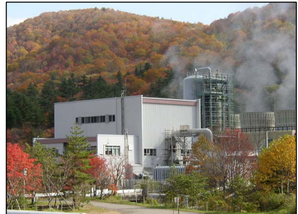
鬼首地熱発電所
