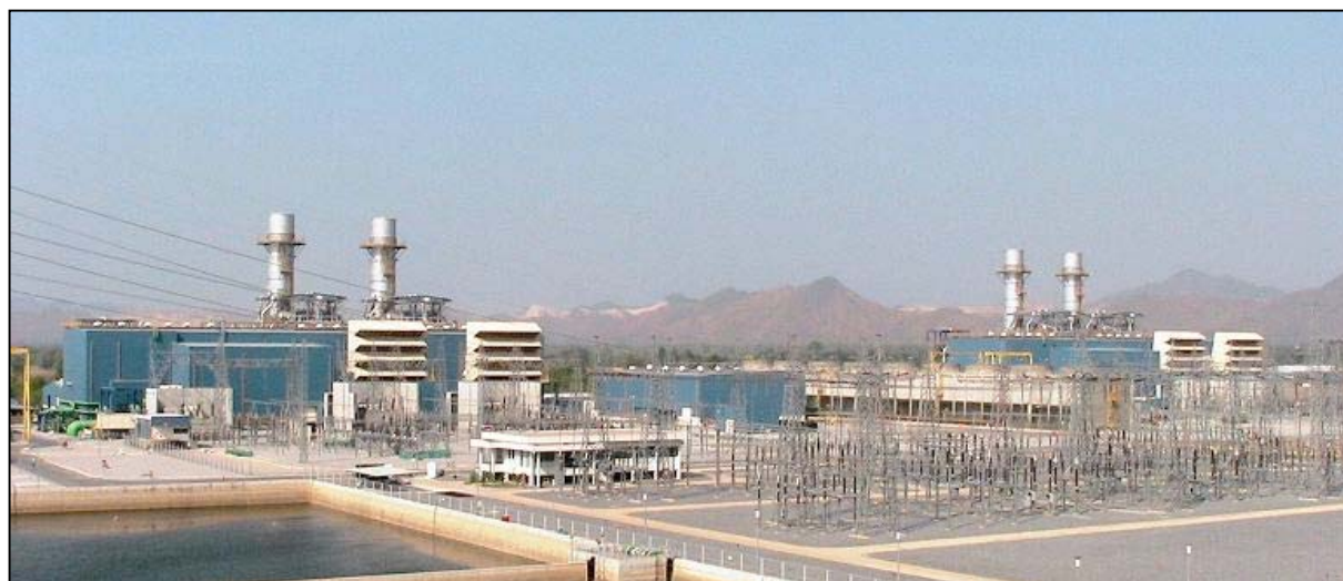
カエンコイ 2 ガス火力発電所（左が 1 号、右が 2 号）
