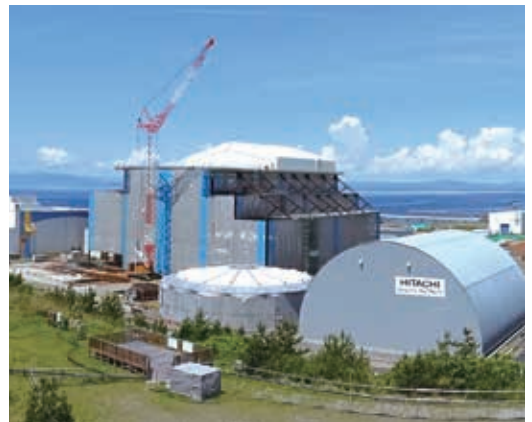
大間原子力発電所。工事本格再開時期を秋に公表予定
