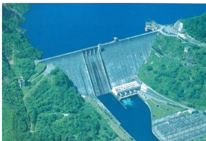
田子倉発電所・田子倉ダム
