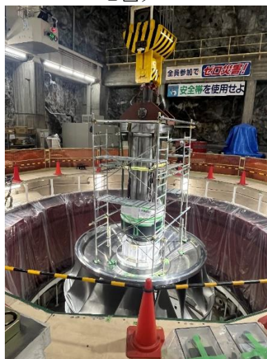
水車ランナ吊り込み状況
