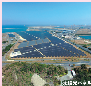
太陽光パネル
