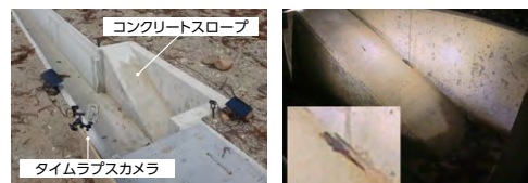
排水溝に設けたスロープ
