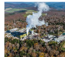
安比地熱発電所
