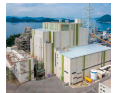
竹原火力発電所
