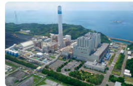
松島火力発電所 (1981年商業運転開始)
