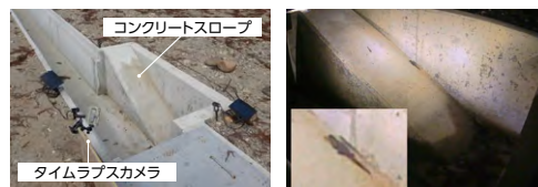
排水溝に設けたスロープ
