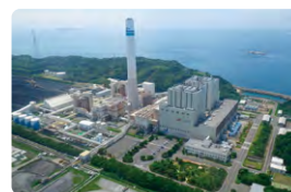
松島火力発電所 (1981年商業運転開始)
