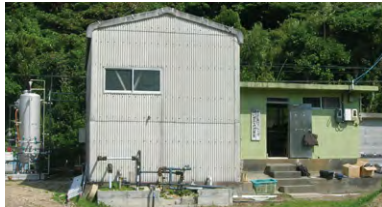
分散型水道（伊島簡易水道）
