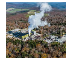
安比地熱発電所
