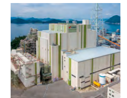
竹原火力発電所
