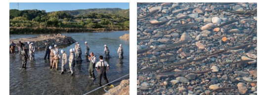
川底の砂利を敷きならす様子
