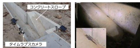
排水溝に設けたスロープ
