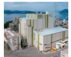
竹原火力発電所
