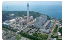
松島火力発電所 (1981年商業運転開始)
