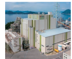
竹原火力発電所
