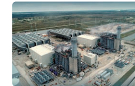
ジャクソン発電所 (2022年商業運転開始)
