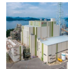
竹原火力発電所新1号機
