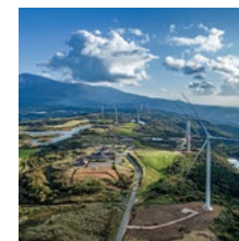
新仁賀保高原風力発電所
