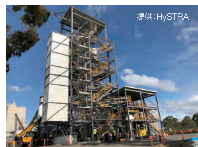
褐炭ガス化炉設備建設工事写真
