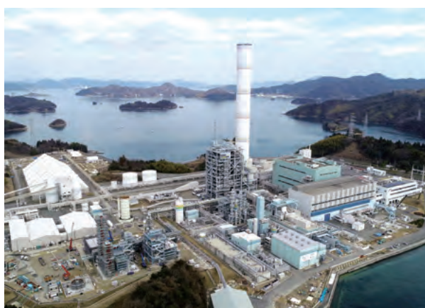
大崎クールジェン実証試験設備(広島県・大崎上島)
