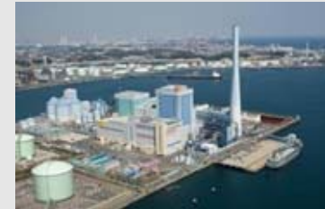
世界最高の熱効率と環境性能を誇る礮子火力発電所
