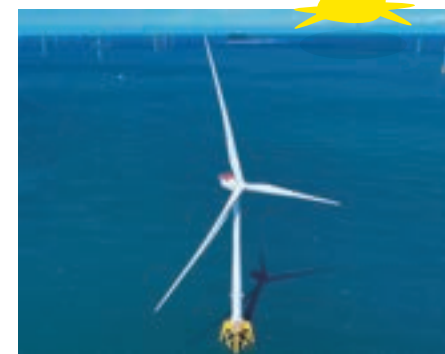
北九州響灘洋上ウインドファーム (風車羽根の最高点は海水面から約200m)
