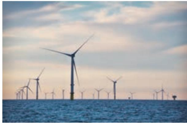
まず今年4月、トライトン・ノール洋上風力発電所が運転を開始しました。この発電所は、イギリス東部リンカーンシャーの沖合32kmの北海上に出力9,500kWの風車を90基設置し、合計出力85.7万kWで発電を行うという大規模な洋上風力発電所です。現在運転中の当社の陸上風力発電所で最大のものが郡山布引高原風力発電所（福島県）の6.6万kWであることからすると、いかに大きな発電所であるかがおわかりになると思います。
