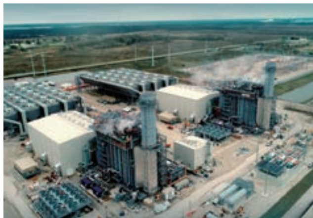
ジャクソン火力発電所
