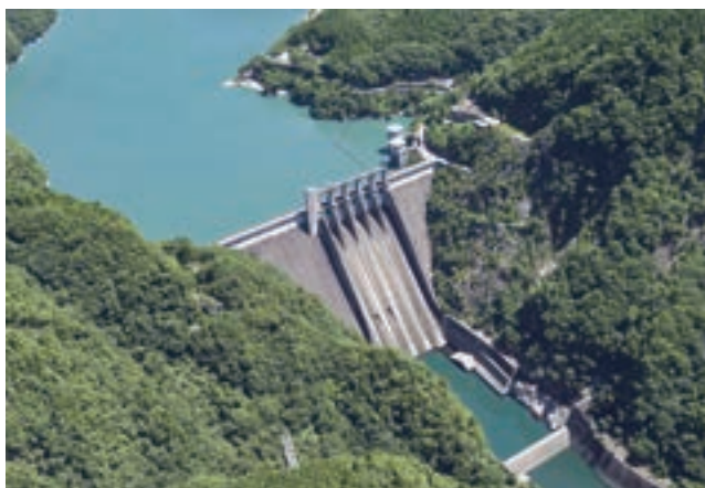
佐久間ダム・発電所
