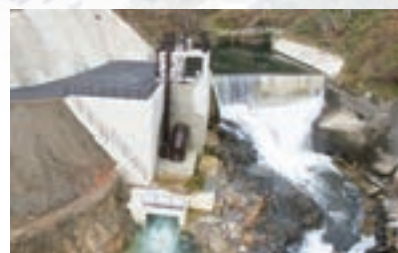
▲九頭竜ダム貯水池と「このき木谷注水口」の遊休落差を利用したこのき谷発電所
