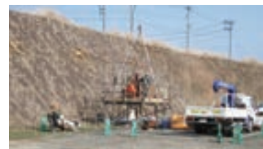
ボーリングマシンの設置作業
