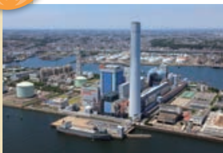
世界最高クラスの発電効率を持つ磯子火力発電所
