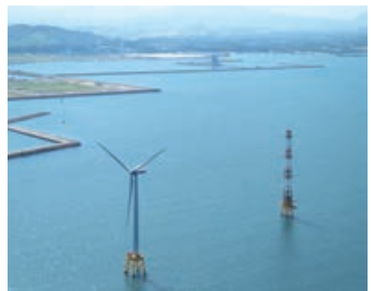
▲洋上風力の実証研究設備(北九州市)
