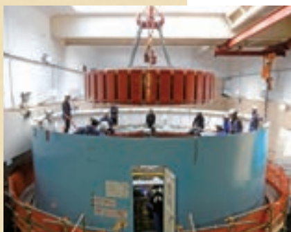
回転子吊り込みの様子
