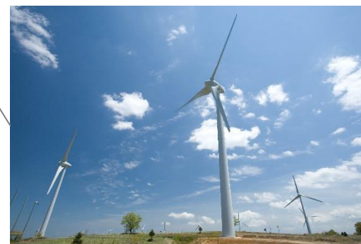
郡山布引高原風力発電所（6.6万kW、福島県）
