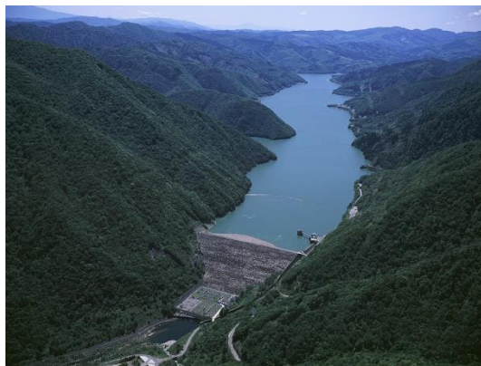
御母衣（みぼろ）発電所 （22万kW、岐阜県）
