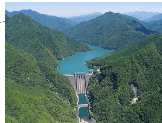
佐久間発電所（35万kW、静岡県）
