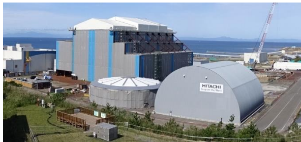
建設中の大間原子力発電所（138万kW、青森県）
