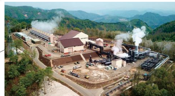
山葵沢（わさびざわ）地熱発電所 （2.3万kW*、秋田県）
