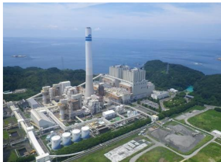
松島火力発電所（現在）
