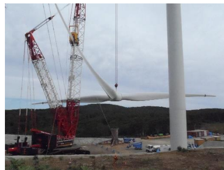
島牧ウインドファーム更新工事 （北海道）
