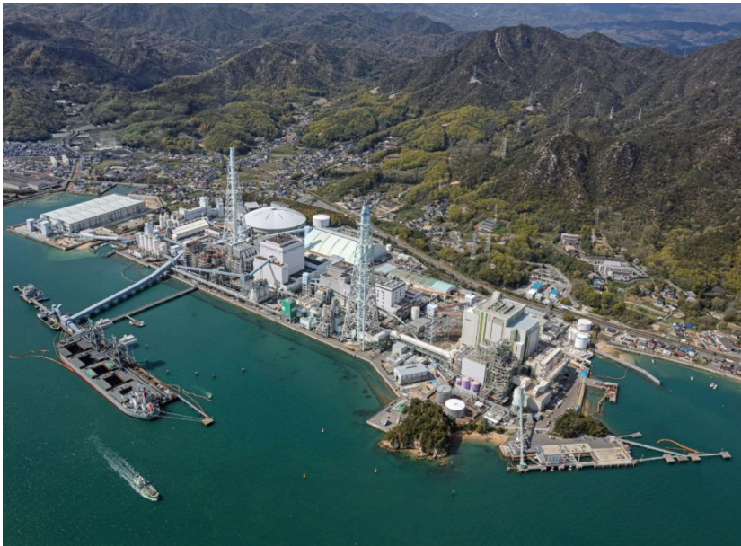
竹原火力発電所（130万kW、広島県）
