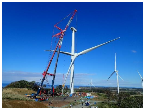
苫前ウィンビラ発電所更新工事 （北海道）
