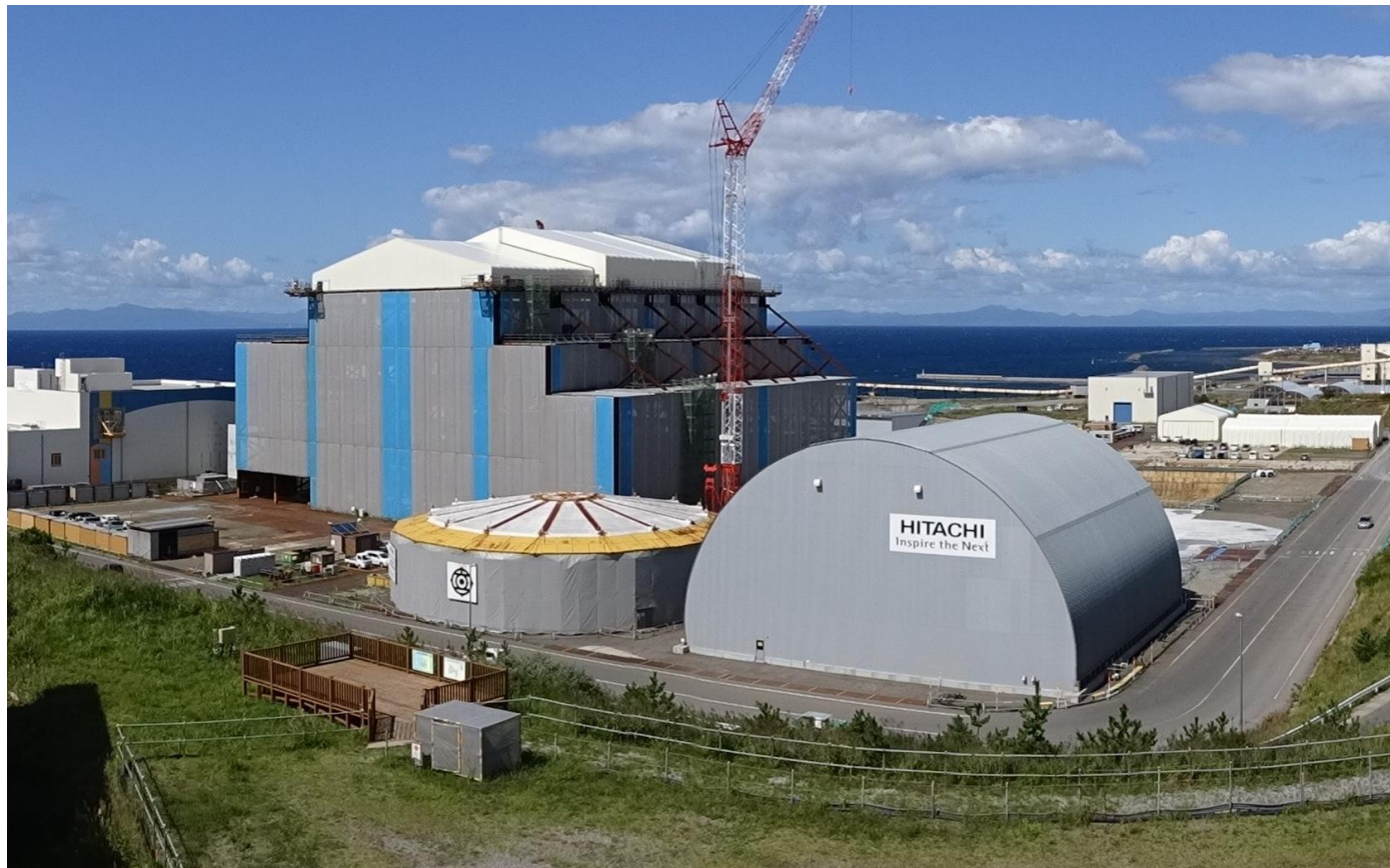
建設状況（2019年9月時点）
