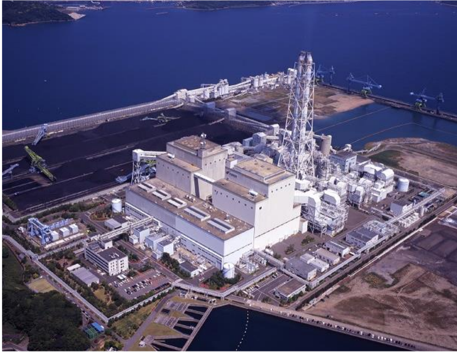
松浦火力発電所 (1990年運転開始・出力200万kW・長崎県)
