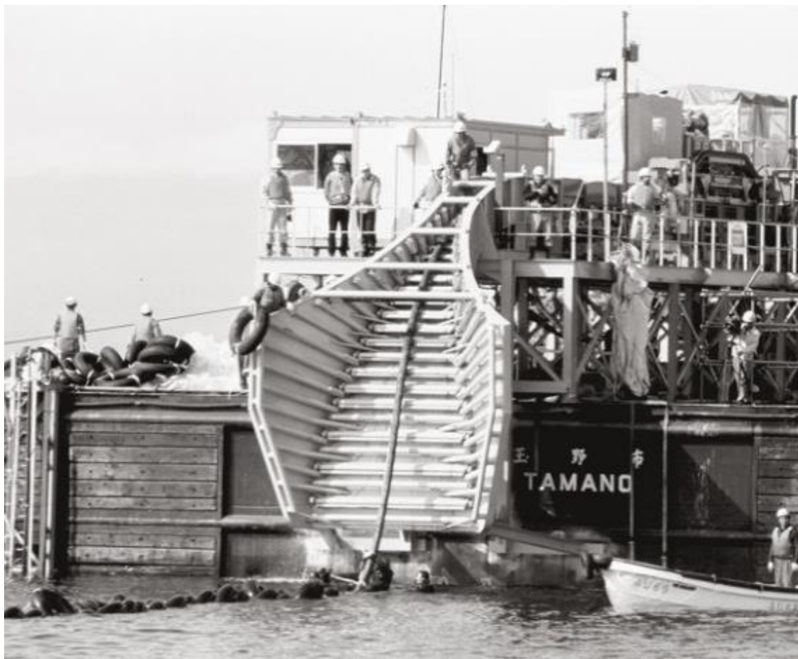
北海道と本州を接続する北本連系設備（1979年運用開始・送電容量60万kW） 海底ケーブル敷設時の様子
