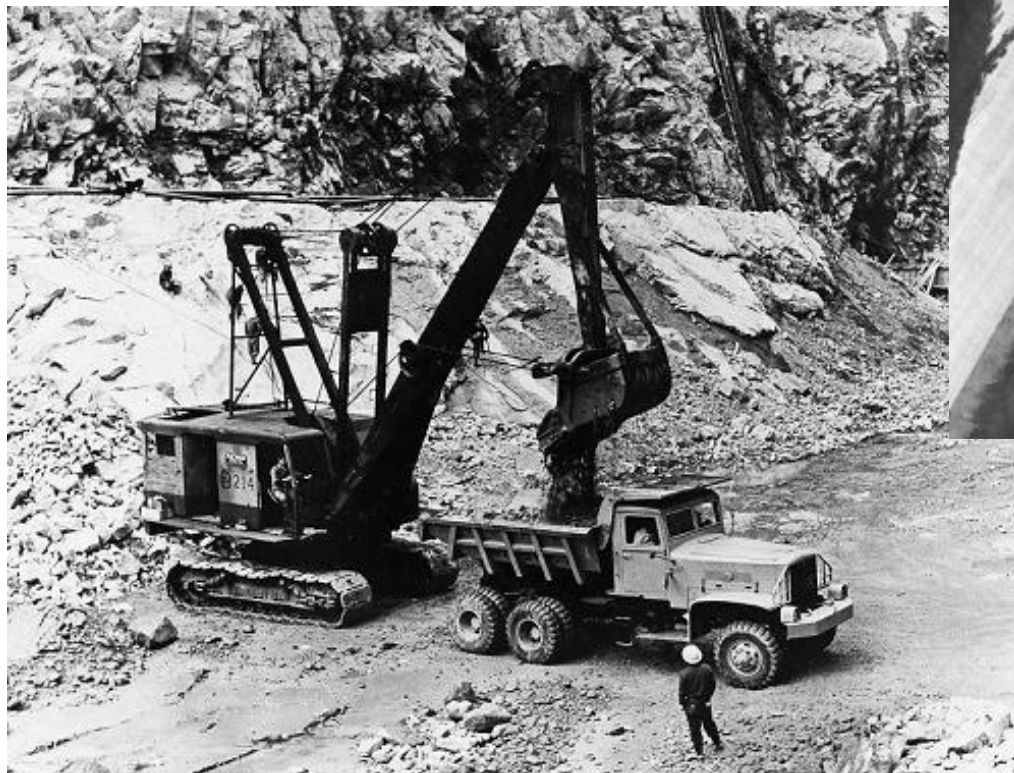
建設中の佐久間ダム
