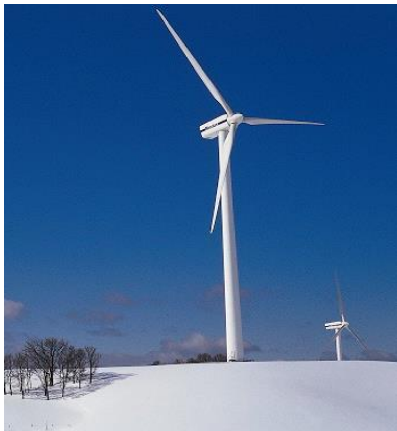
当社初の風力発電所となる苫前ウィンビラ発電所 (2000年運転開始・出力3.06万kW・北海道)
