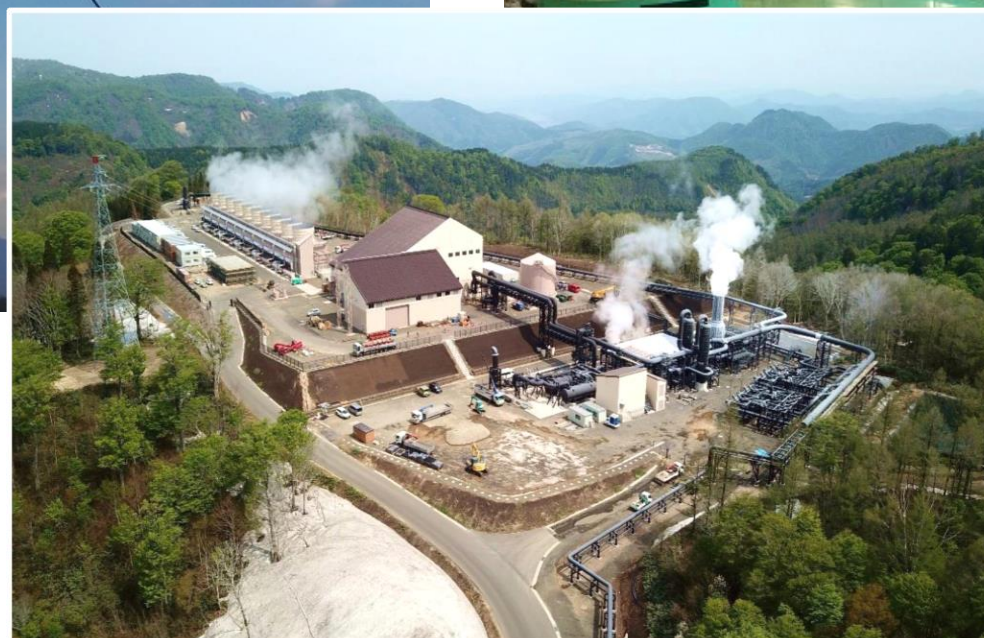
国内23年ぶりとなる大規模地熱発電所 山葵沢地熱発電所 (2019年運転開始・出力4.62万kW・秋田県)
