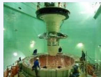
秋葉第一発電所のリパワリング
