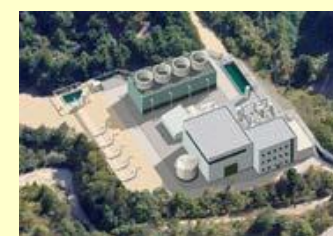
鬼首地熱発電所完成予想図 (リプレース工事中)
