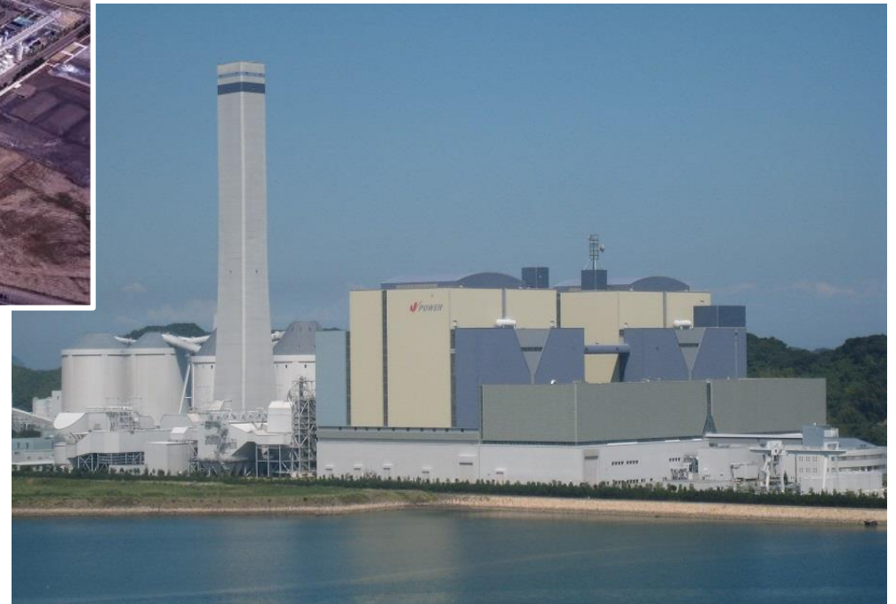
橋湾火力発電所 (2000年運転開始・出力210万kW・徳島県)
