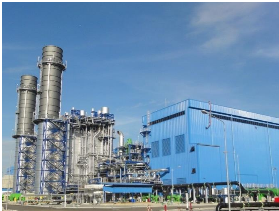
ウタイガス火力発電所（2015年運転開始・出力160万kW・タイ）
