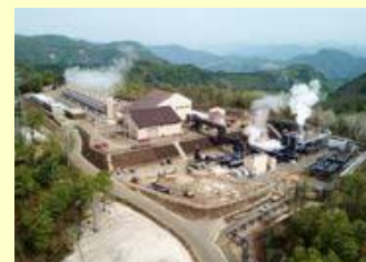
山葵沢地熱発電所
