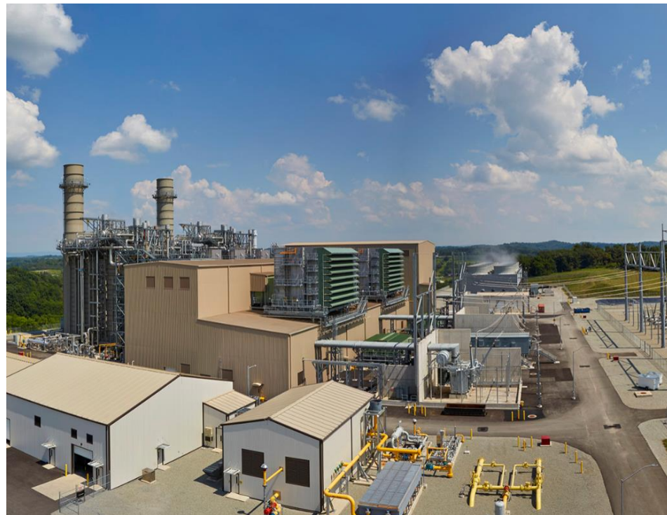
ウエストモアランド火力発電所（2018年運転開始・出力92.6万kW・アメリカ）
