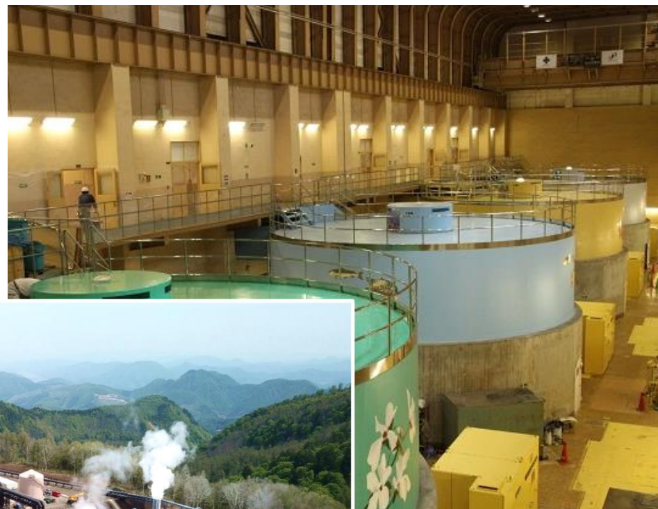
水力発電所のリパリング 田子倉発電所 (2012年リパリング完了・福島県)
