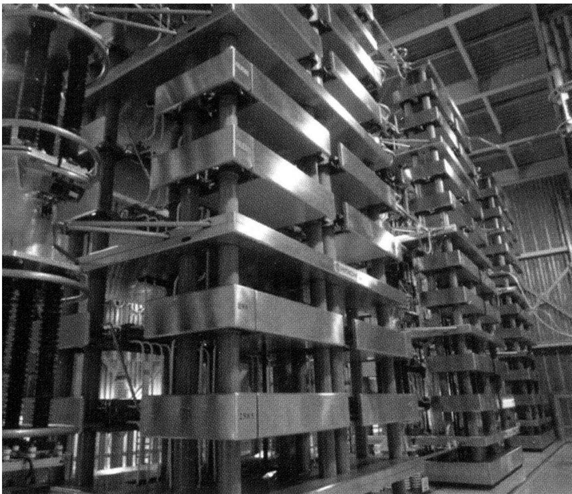
佐久間周波数変換所の設備（サイリスタバルブ）（1965年運用開始・変換容量30万kW・静岡県）
