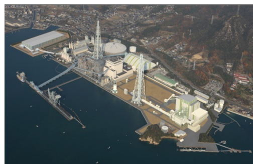
更新工事が進む竹原火力発電所
