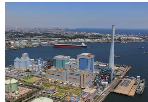
磯子火力発電所（神奈川県）
