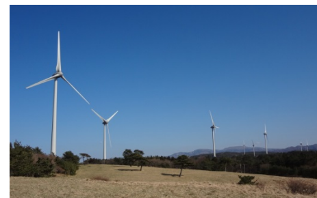
大間風力発電所（青森県）
