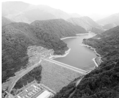
大規模揚水発電所である奥清津発電所の運転を開始
