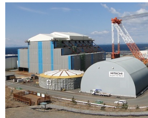
当社グループ初の原子力発電所となる 大間原子力発電所の建設を開始
