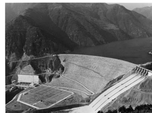
トルコ・アルツンカヤ水力発電所の施工管理を実施
