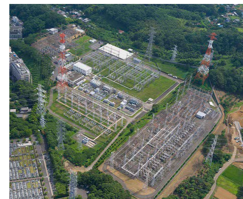
西東京変電所（東京都）
