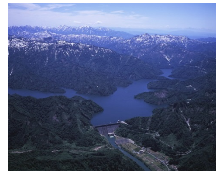
田子倉発電所 (福島県)
