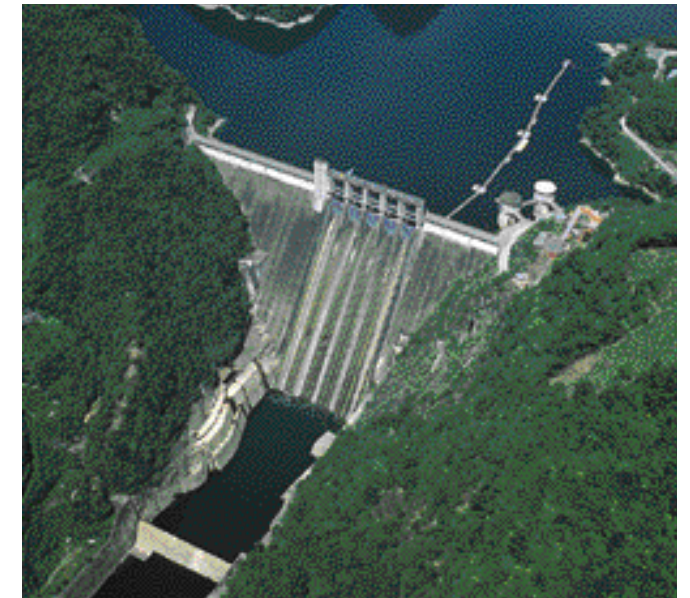
佐久間発電所(静岡県)
