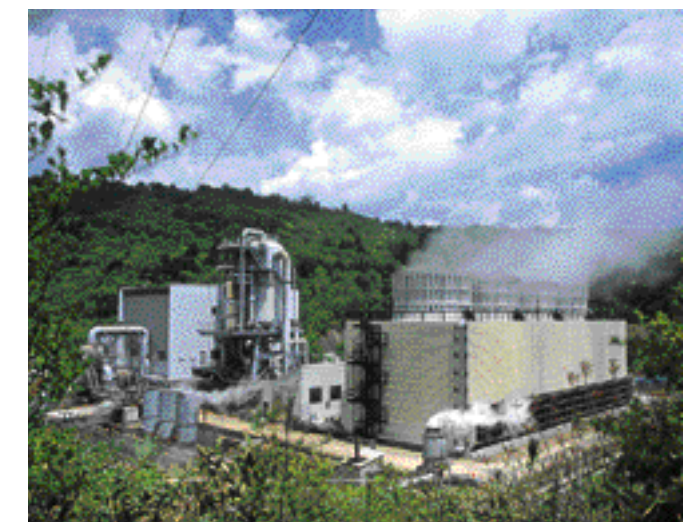
鬼首地熱発電所(宮城県)
