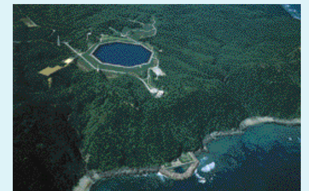
沖縄やんばる海水揚水発電所(沖縄県)
