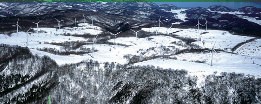
郡山布引高原風力発電所(福島県)
