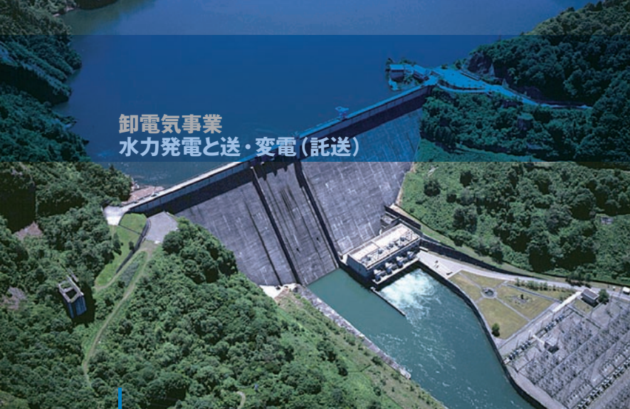
田子倉発電所（福島県）
