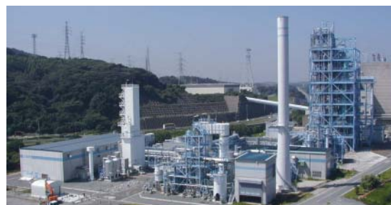
EAGLEパイロット試験設備 (若松研究所／福岡県)
