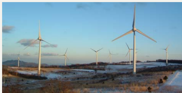
郡山布引高原風力発電所は、福島県郡山市の会津布引高原において2005年5月より建設を進めてきたもので、風車基数33基、合計出力は国内最大の65,980kWです。発生する電力の全量を東京電力（株）に販売しています。
