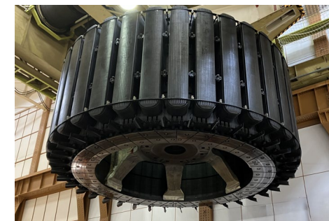
既設1号機 発電機回転子 吊り出し
