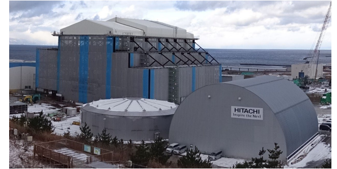
建設状況（2024年12月末時点）
