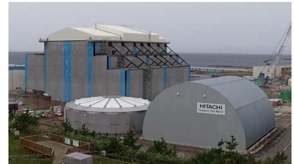
建設状況（2024年9月末時点）
