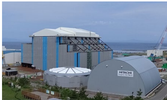
建設状況（2024年6月末時点）
