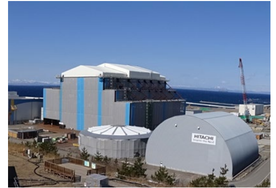
建設状況（2024年3月末時点）
