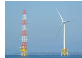
【NEDO実証試験】 北九州市沖で着床式洋上風車 2011~2017.3
