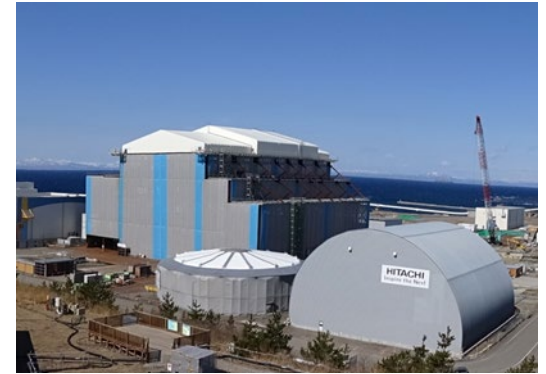
建設状況（2024年3月末時点）
